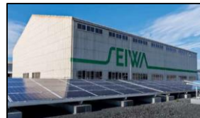
島根工場全景
