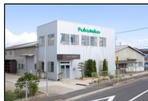
①工場外観
